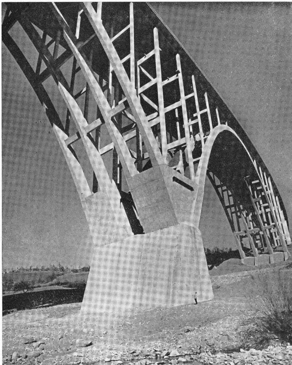
Fig. 27. - Viadotto sul Torrente Merizzano per l'Autostrada del Sole sul tratto Firenze-Bologna. Comprende, principali, N. 2 arcate di luce  $L = 87,50$  m; freccia  $f = 41,00$  m. La pila centrale è alta 20,0 m, ha struttura scatolare nervata in parete sottile.
