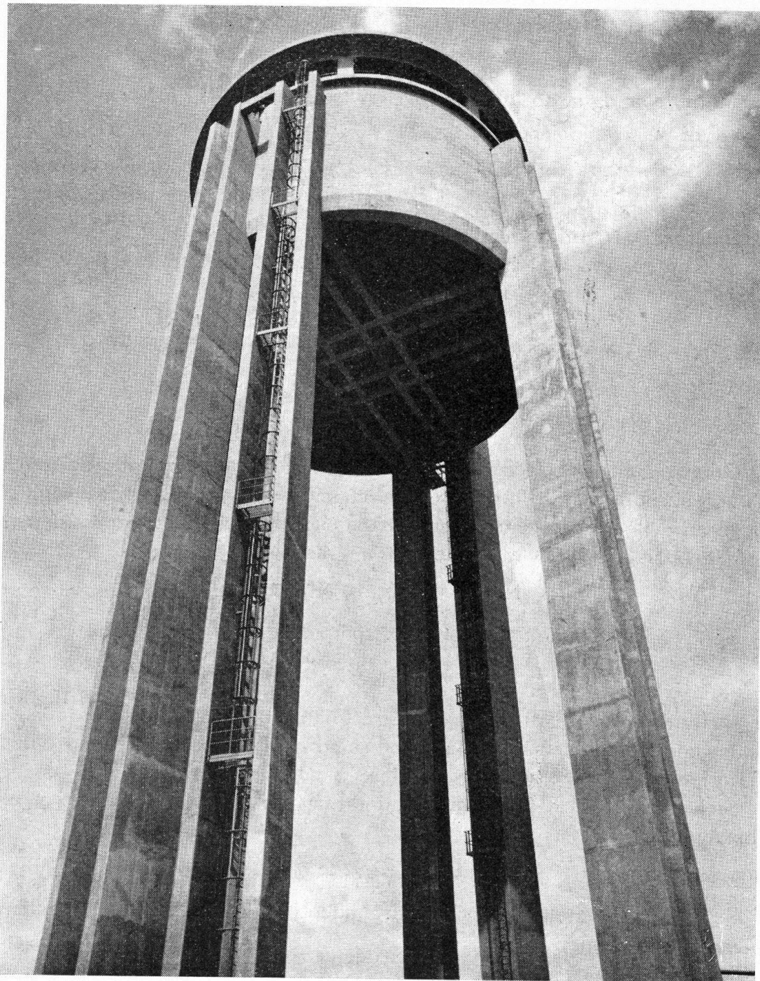
I sostegni di questo altissimo serbatoio da 3000 \text{ m}^3 — senza traverse — sono stati calcolati con questi criteri.
